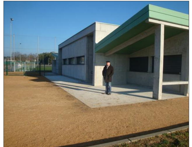
■ Un nouveau bâtiment abrite les vestiaires multisports au complexe sportif du parc de l'Hippodrome. Photo Georges MALSOT
